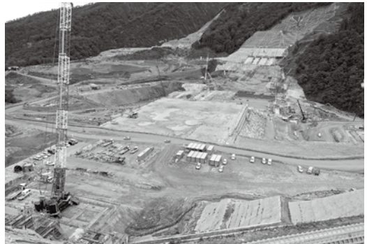
右岸天端展望台より正面（左岸天端）を望む
