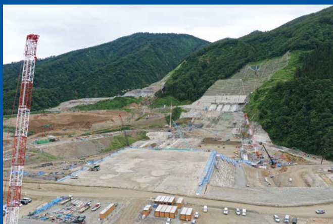
成瀬ダム建設現場全景 手前側が将来のダム右岸
