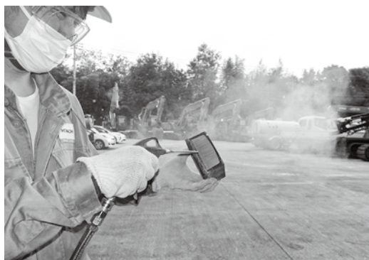
エアブロー作業時の粉塵飛散状況
