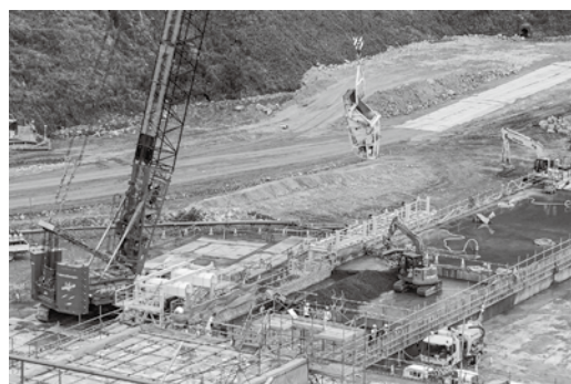
コンクリートを打設中
