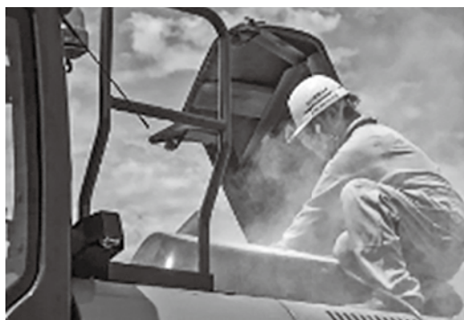
重機エアブロー作業時の粉塵飛散状況
