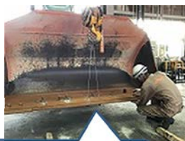
直接ワイヤーで吊り上げ。
