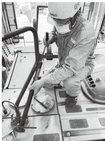
考案後の作業状況① ポンプセット～ポンピング（20～30回程度）
