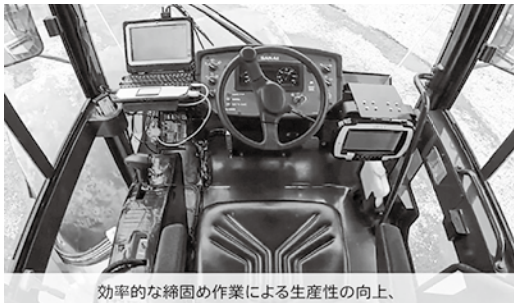
図7 自律走行式ローラの運転状況
