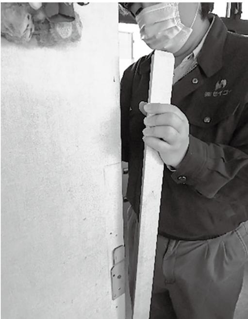
写真7 着脱時のコーナープロテクター
