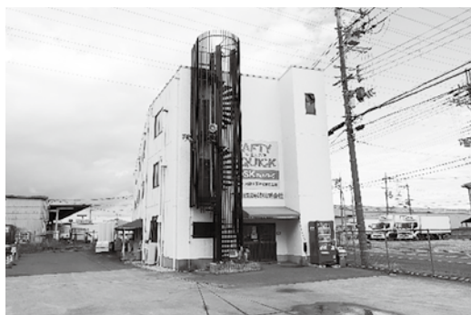
大阪支店全景
