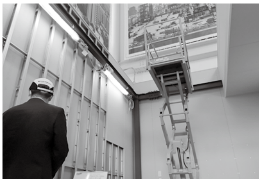
無足場工法の展示にももちろん高所作業車
