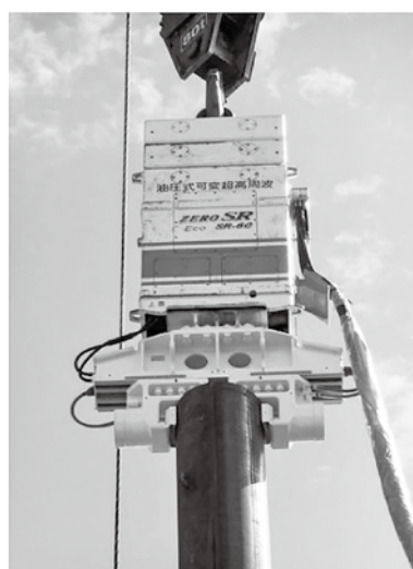
写真 2 SR-60 鋼管杭施工
