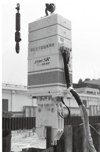
写真 1 SR-60 鋼矢板施工
