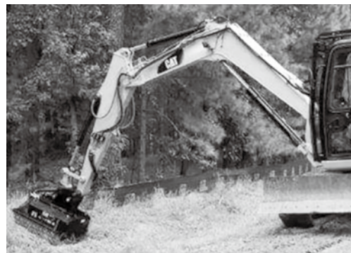
写真9 草刈機アタッチメント&amp;走行同時作業
