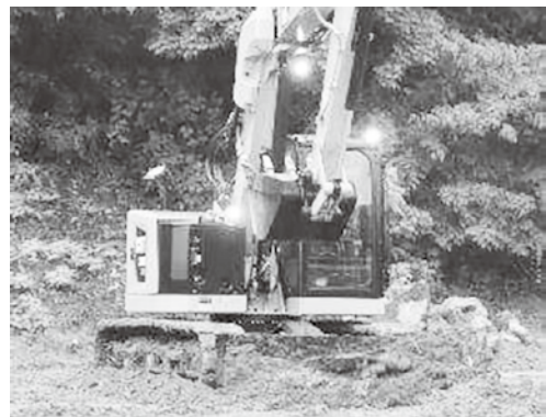
写真8 ブレード整地作業
