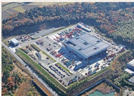
工場建屋屋根全面に 設置された太陽電池
