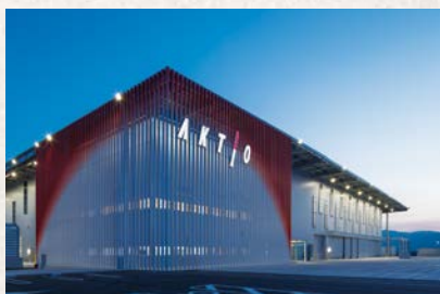
グラデーションルーバーと北面ファサード (夜景)
