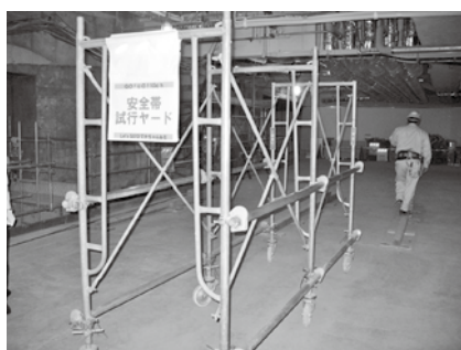
安全帯の確認を行う試行ヤード
