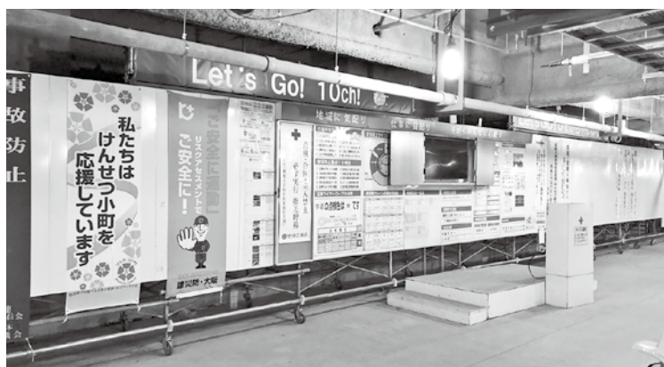
安全朝礼やラジオ体操を行う地下スペースの様子
