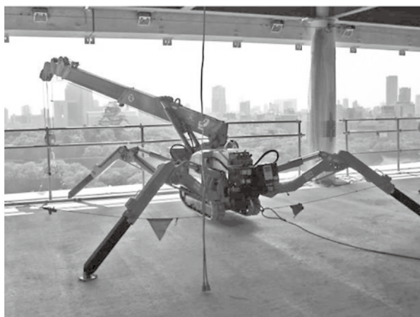
上階ではカニクレーンがガラスユニットを引っ張り上げる
