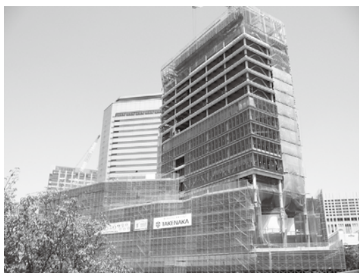
今回訪問した読売テレビ新社屋工事現場
