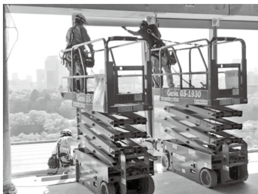
高所作業車も使用して最終取付
