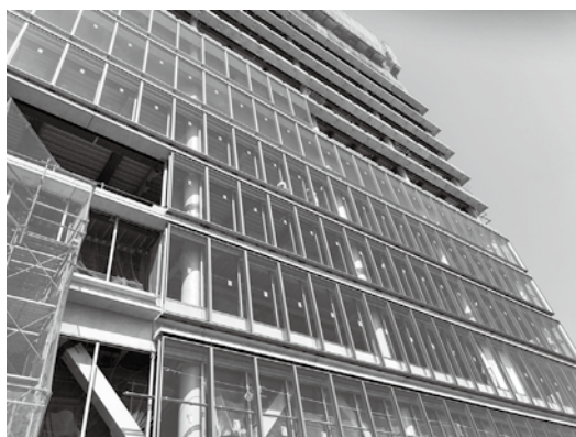
設置されたガラスのユニットの様子
