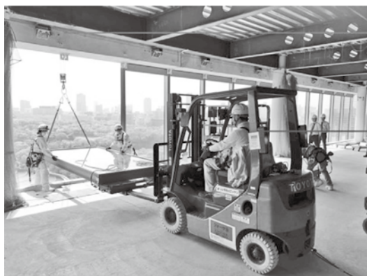
フォークリフトを使ってガラスユニットを外に送り出す
