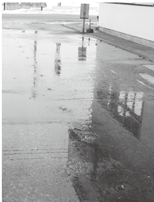
融雪水が出ている状況
