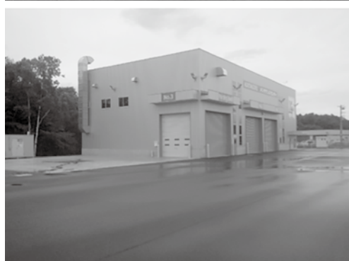
メンテナンスセンター（延べ床面積275坪）
