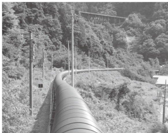
旧吾妻線の跡地を有効活用し設置されたベルトコンベア
