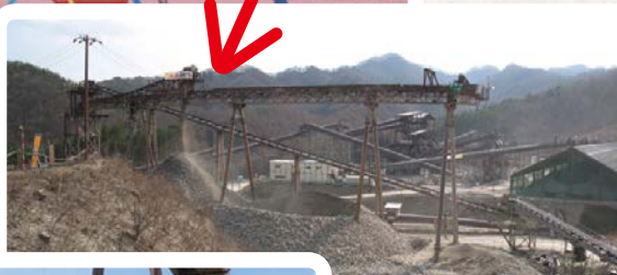
一次サージ設備
