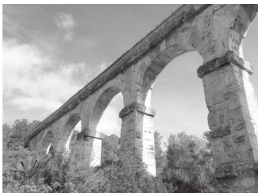
水道橋を見上げると青い空が…
