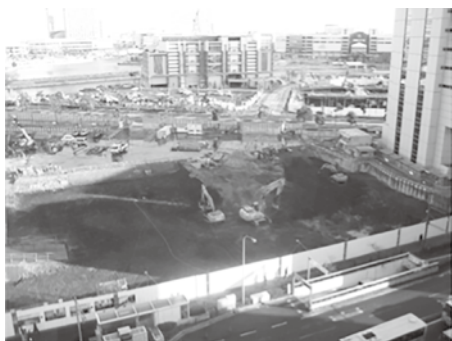
特自検対象機械が並ぶ建設工事現場
