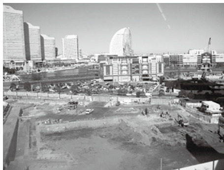
支部から見た横浜市新庁舎建設工事現場
