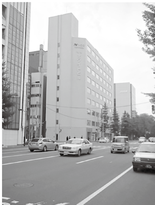
事務所が入っているビルの外観
