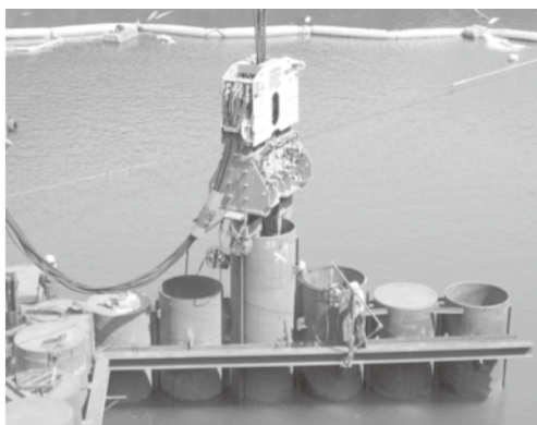
油圧バイブロハンマーによる打設状況
