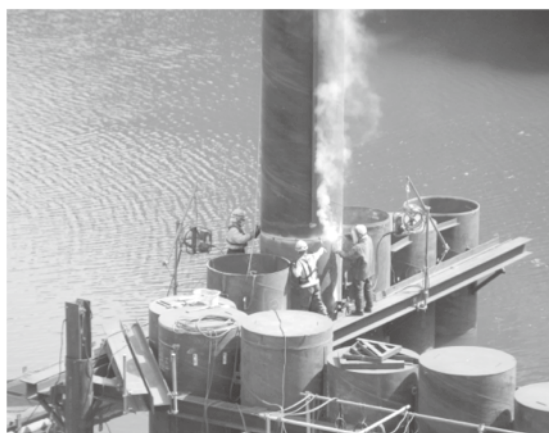
鋼管矢板の継手溶接状況
