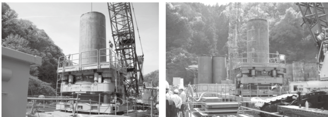
全周回転掘削機による掘削状況（仮栈橋上にて）
