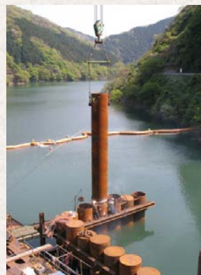
◀ 鋼管矢板吊り込み状況 ▶
