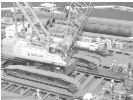
油圧バイブロハンマーによる打設状況
