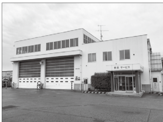
新潟営業所 工場棟
