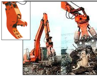
日立建機株式会社製、同社提供 (上写真右はコンクリート圧砕機(大割)・左は同(小割))
