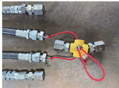
2本の油圧ホースに取り付けた状況
