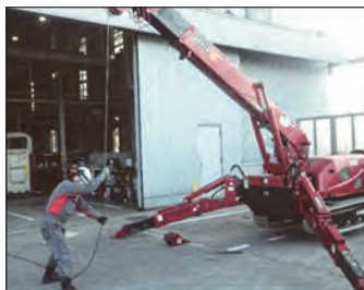
従来の作業状況
