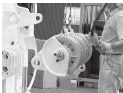
写真3 吊りシーブブロック取付け
