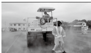
写真2 舗装現場で発生する湯気
