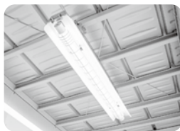
安全増防爆型蛍光灯(室内)
